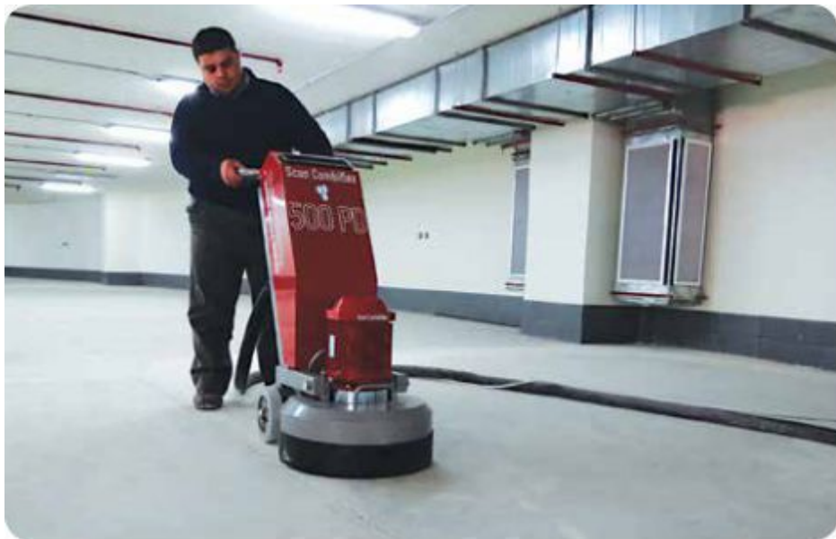
Usuwanie powłok i przygotowywanie posadzki
