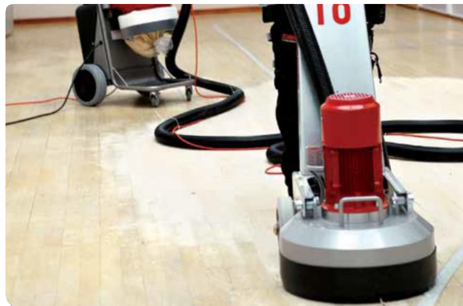
Szlifowanie podłóg z twardego drewna i parkietów
